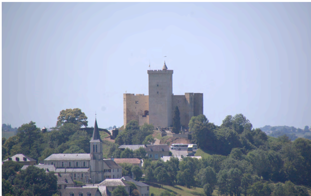
Les travaux de restauration du Château de Mauvezin (Hautes-Pyrénées) ont permis de révéler le savoir-faire et le talent de Belmir Dos Reis, Grand Prix des Trophées SOCLI 2011.
